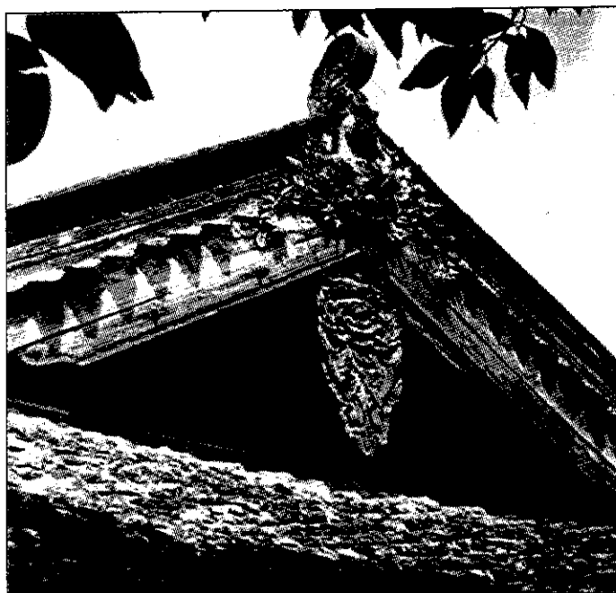
Hình 1-11b. Ở đầu hồi để bảo đảm thông thoáng dưới mái "phong thủy" ( hay "khu đi") bao giờ cũng để ngỏ. Đình chùa thì có "yếm" hay "lá gió" trang trí.
