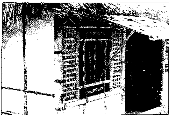
Hình 1-7. Vật liệu quen thuộc ở đồng bằng sông Hồng và kỹ thuật thích hợp, tre, lá dứng bức vách bùn vào cốt tre
