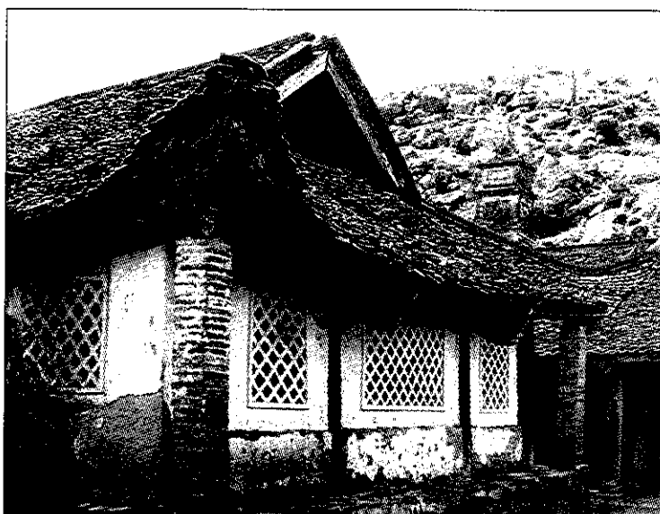
Hình 1-11c. Tường thông thoáng quanh nhà xây từ khi chưa dùng bê tông cốt thép ở chùa Phật Tích.
