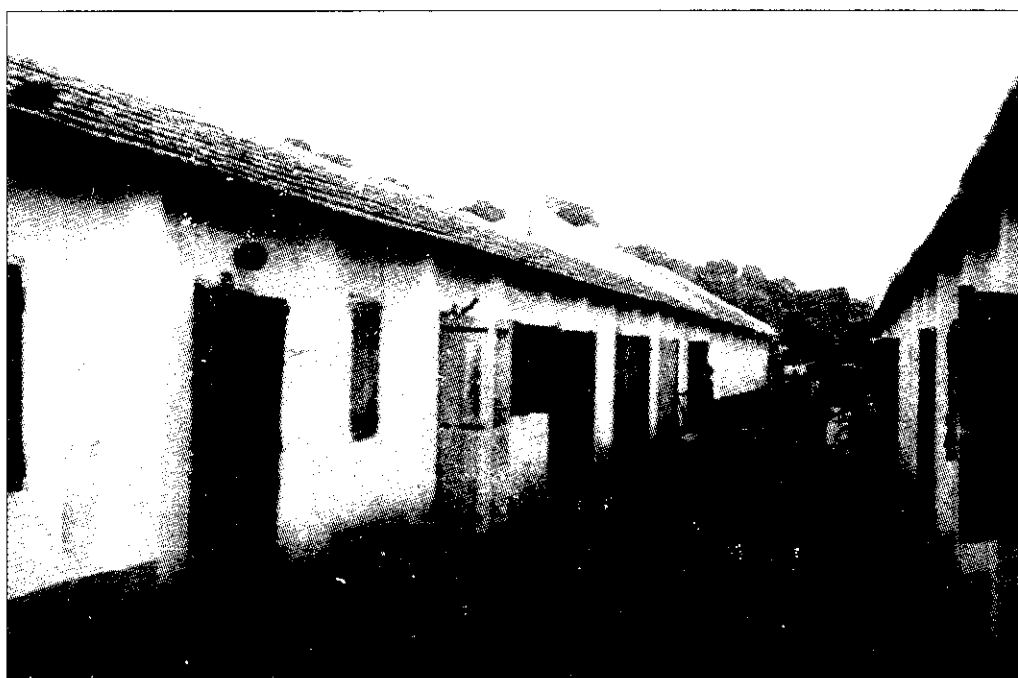
Hình 6-28. Nhà ở của công nhân mỏ than Hòn Gai
