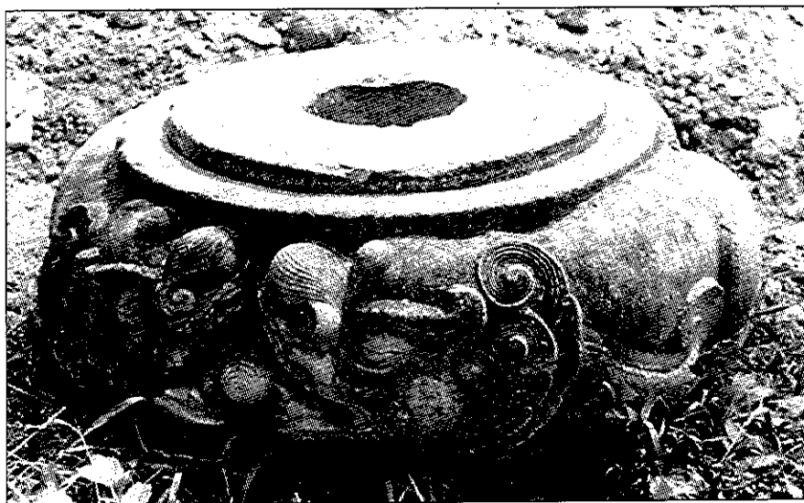
Hình 1-19. Tầng bằng đá kê chân chốt còn lại sau khi chùa Phật Tích (Bắc Ninh) bị phá hủy.
