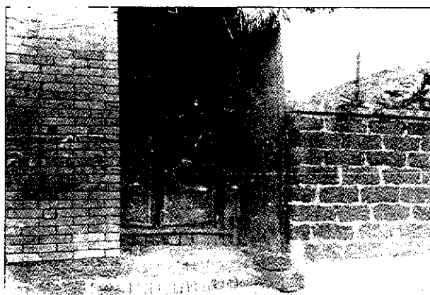
◀ Hình 1-4. Một tổ hợp vật liệu xây dựng có tại chỗ : tre nửa là, dẹt bùn rom quanh cổng, gạch nung ở bậc ra vào tường đá ong, tường gạch mộc quanh nhà.
